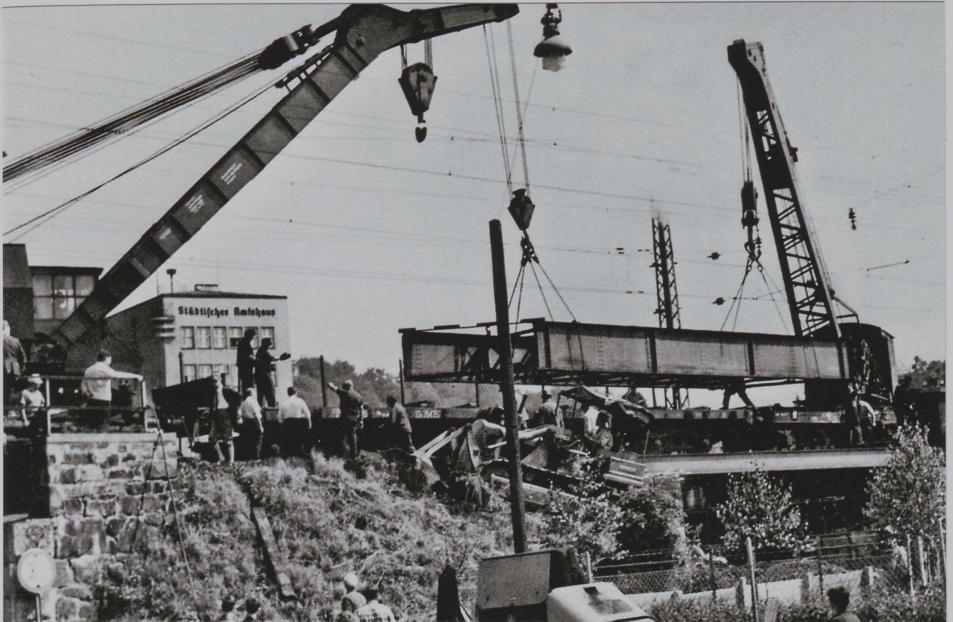
o.: 1967; Schwieriger Austausch des alten Tragwerks über dem Mühlbach. u.: 1968; Elektrifizierung der KRB, Arbeiten an der Leitung in der Forstheide.
