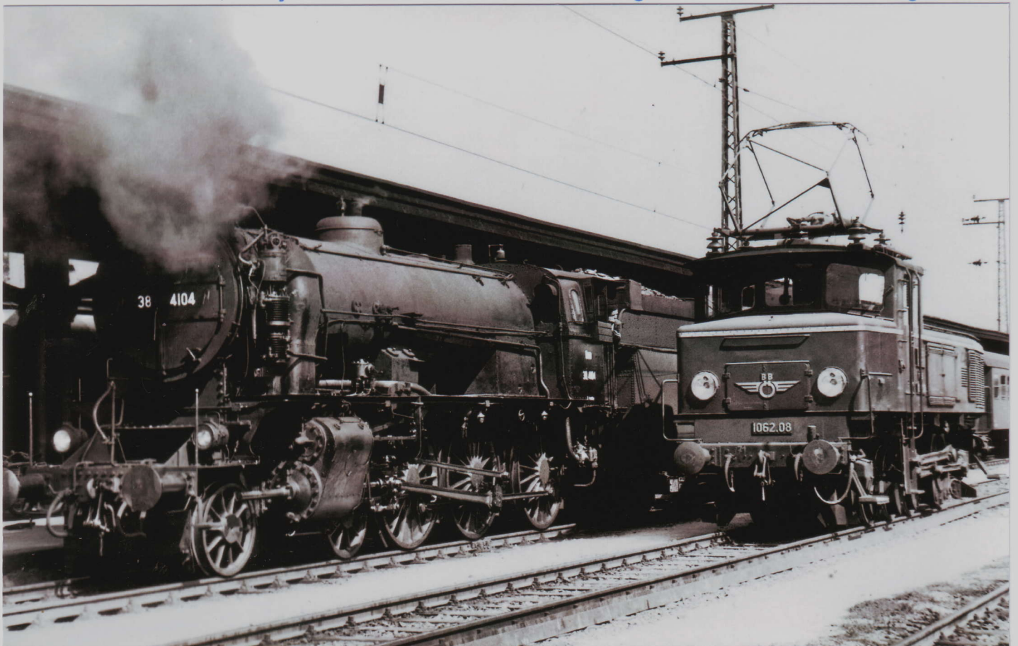
u.: 1959; Übergangszeit bei den „Triebfahrzeugen“, Dampflok neben E-Lok, E-Lok Reihe ÖBB 1062, Baujahr 1955, diese waren vorwiegend im Vershub eingesetzt.
