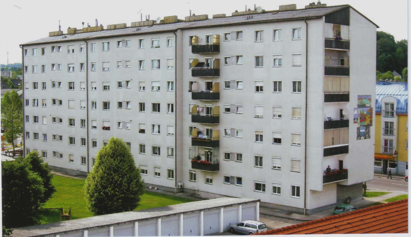
o.: 1966/67; Die „Wohnbaugesellschaft der ÖBB“ erbaute das Wohnhaus Wiener Straße 34, 36 u. 38 mit 57 Mietwohnungen.
